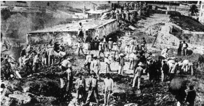
Figura 1: Derribo de la muralla y Puerta de Santiago
